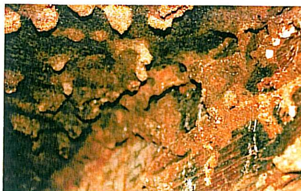
Holzkonstruktion mit umfassendem Insektenbefall
