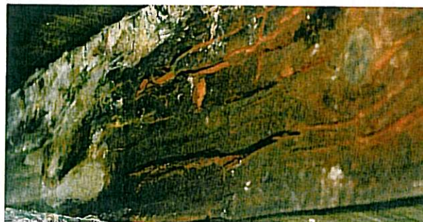
Holzkonstruktion mit umfassendem Insektenbefall
